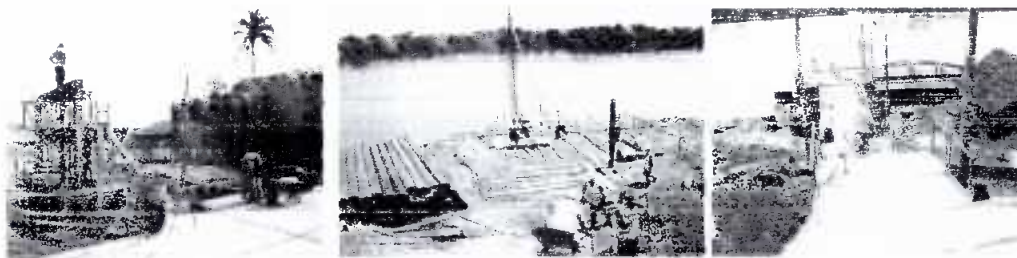
Construcción Embarcadero Fluvial del Estrecho
